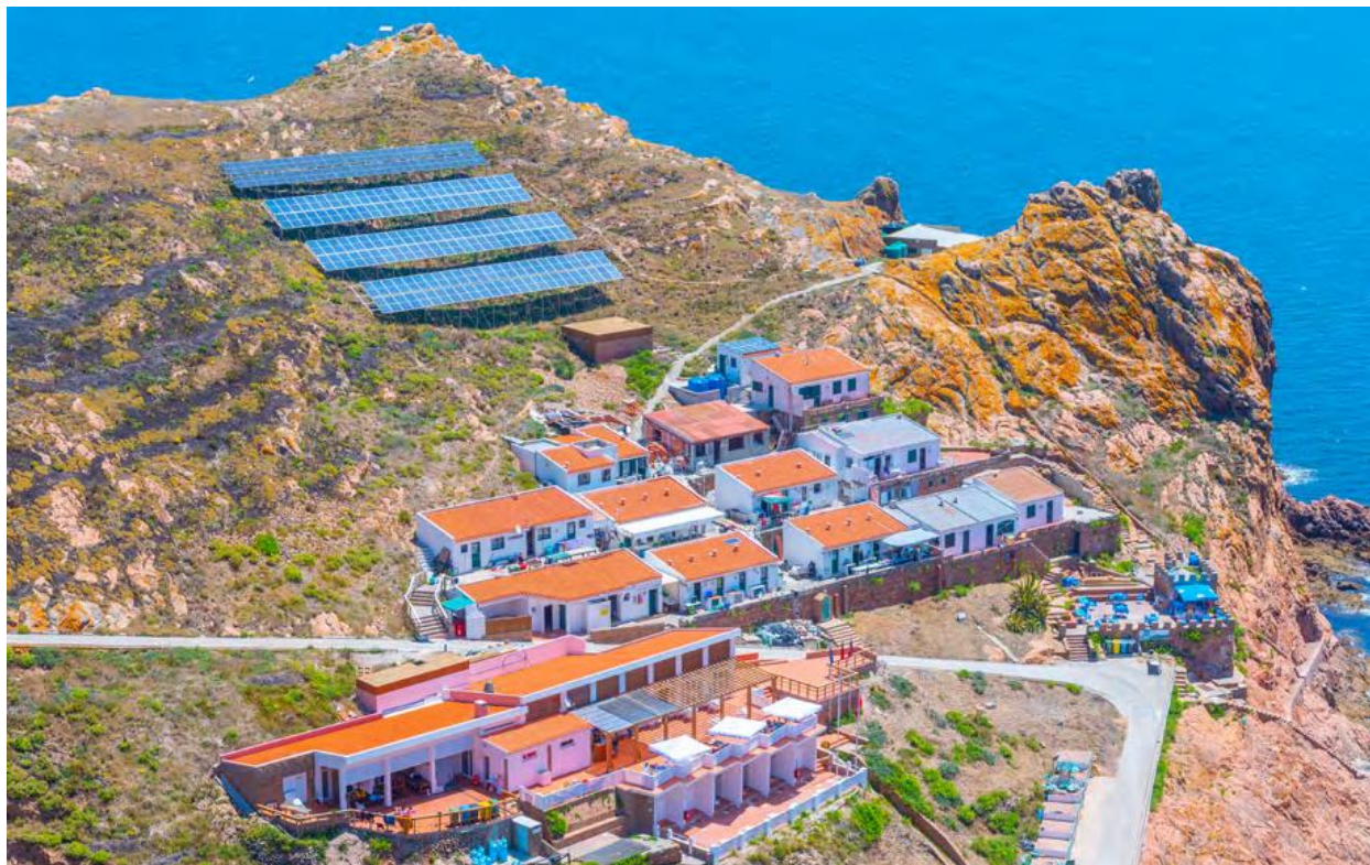
Sonnenkollektoren in der Nähe eines portugiesischen Dorfes © dudlajzov - Adobe Stock
