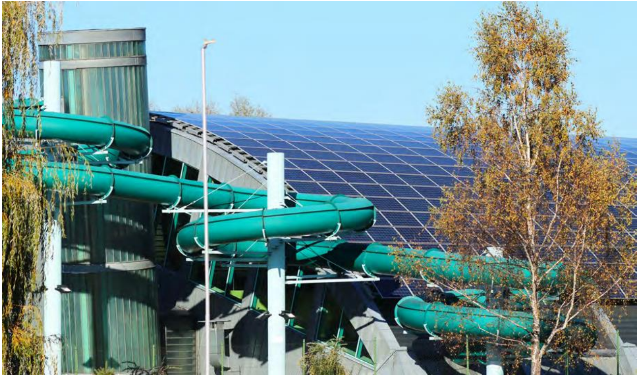
Sonnenkollektoren auf einem öffentlichen Schwimmbad in Jaslo, Polen © Xato Lux - Adobe Stock
