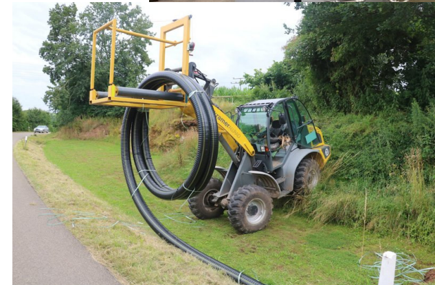
Bildquelle: Verlegung PE-Xa Leitung Enerpipe Übergabestation Firma Kring
